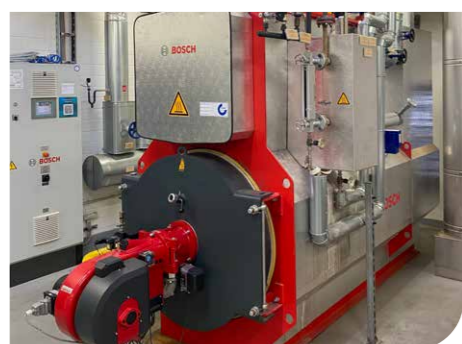
Bild: Schwarzdampfkessel
